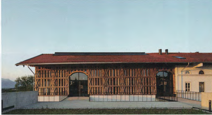
Die Fachwerkfassade des Möglhofs in Rimsting spielte aus Sicht des Denkmalschutzes eine wichtige Rolle. Das Bundwerk durfte nur behutsam geöffnet werden, um mehr Tageslicht hineinzulassen Foto: Jonathan Sage
