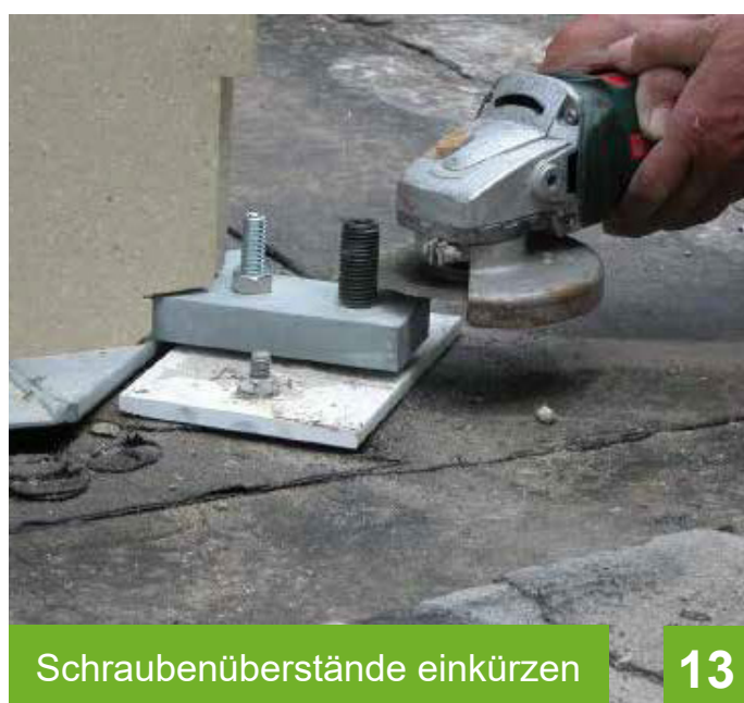
Mit M20 in der Höhe ausrichten
