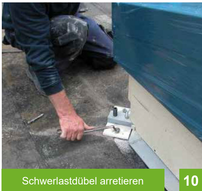
Mit M20 in der Höhe ausrichten
